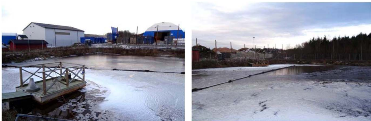
Figur 1. Luftet lagune for lokalrensning av sigevann [15]
